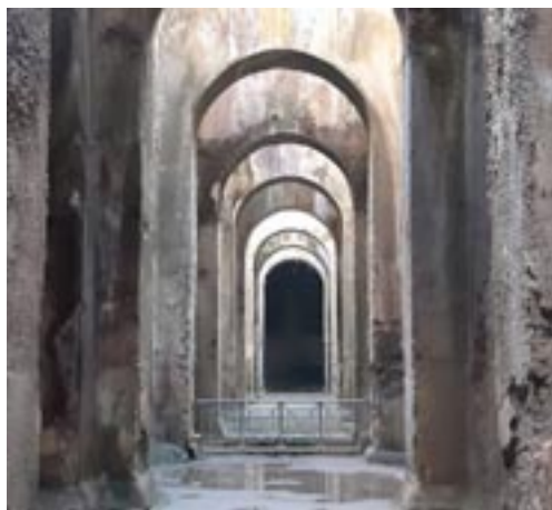
Fig. 10: “Piscina mirabile”: una delle maggiori cisterne romane conosciute, interamente scavata nel tufo (lunga 70 m, larga 25 m, alta 15 m), suddivisa in cinque navate separate da quattro file di dodici pilastri (foto D. Carro).
